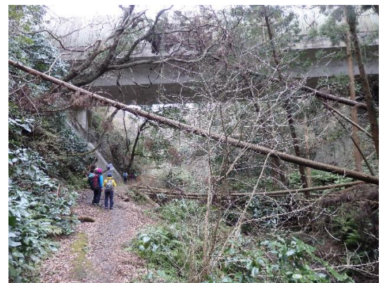
南郷トンネルの連結部分
