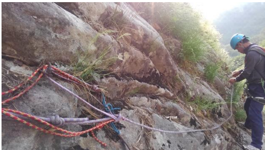
フィックスザイルの補修をする金井代表
