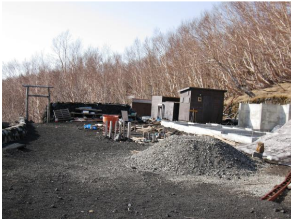
砂払五合目の山小屋は建て替え中
